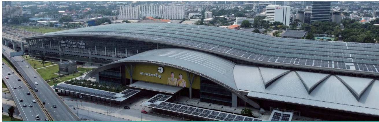
泰国隆披尼阿披瓦中央车站-泰国最大铁路枢纽 地点：泰国曼谷 配置：9.728MWp屋顶光伏系统，安装逾15,000块飞虎系列组件 模式：自发自用
