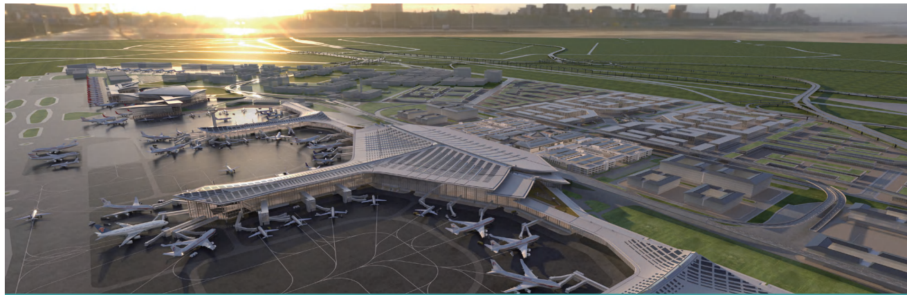
太原武宿零碳机场-国内首个零碳航空枢纽 地点：中国山西太原 配置：总装机108.5MW，其中跑道两侧光敏感区域采用约40MW飞虎防眩光组件 模式：自发自用，光伏+中深层地热+跨季节冷热调蓄+多形式储能
