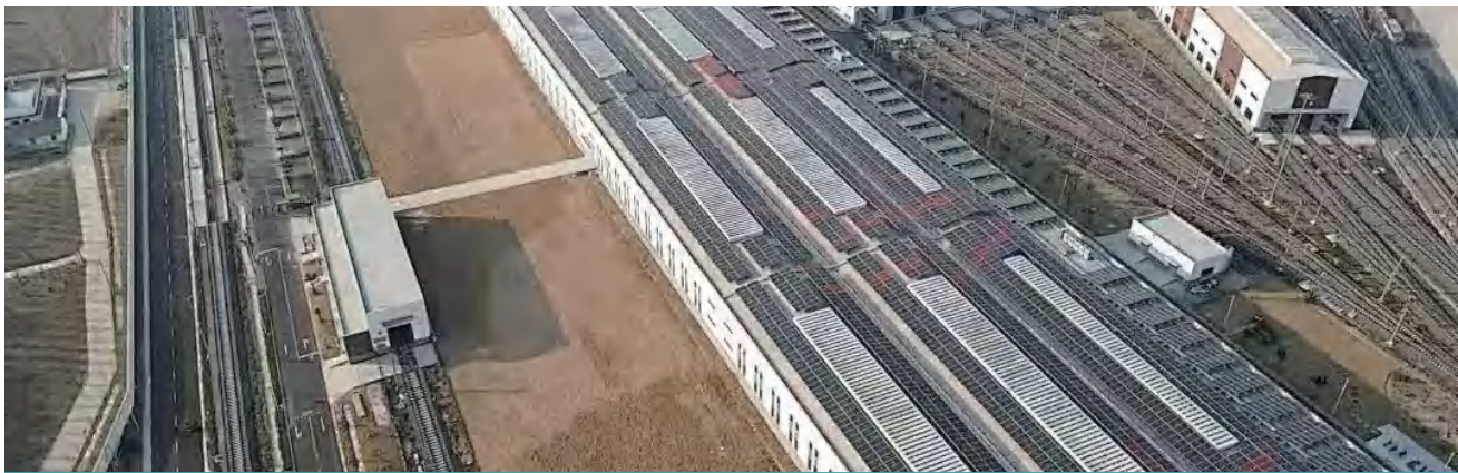
上海地铁14号线6.56兆瓦 项目地点：上海封浜基地 光伏容量：6.56MWp光伏系统，投入运营后首年可产生绿色电力约670万度。 模式：自发自用
