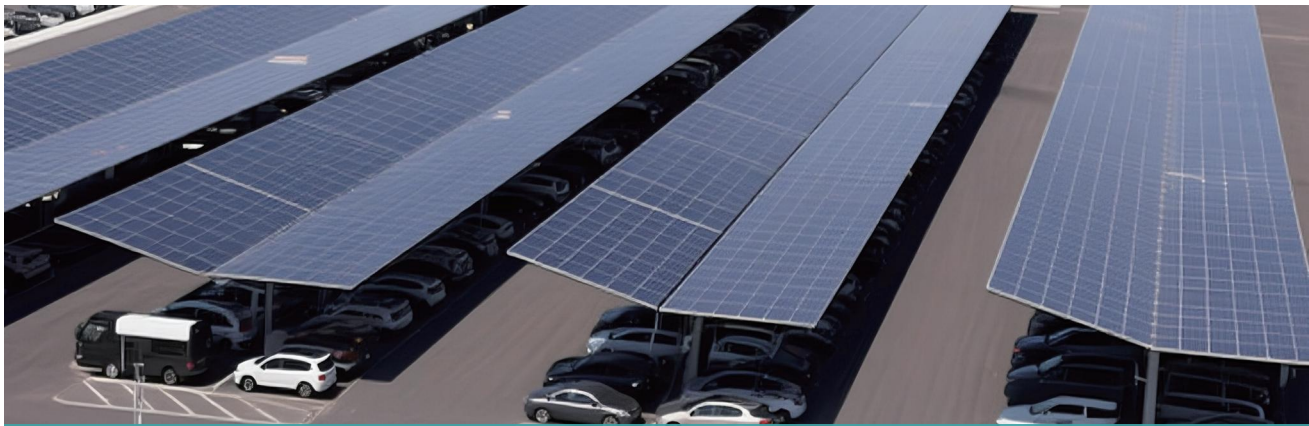
黎巴嫩车棚 地点：黎巴嫩马特恩（Matn）区 光伏容量：250kW 光伏系统，240块晶科飞虎3组件 储能容量：3.34MWh 模式：自发自用
